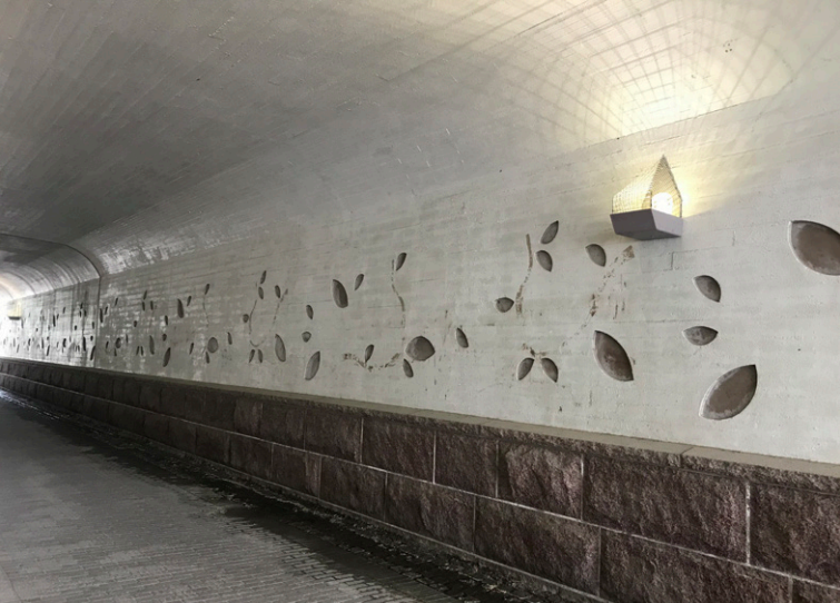
Keravan keskustan alueella risteilee useita alikulkuja. Panostus niiden suunnitteluun näkyy.
